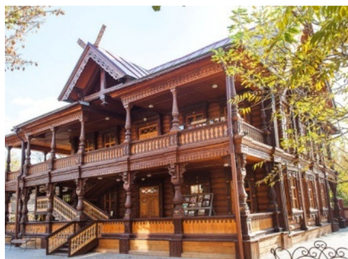
Рис. 1. Дом Тетюшинова после реставрации 2014 г.
