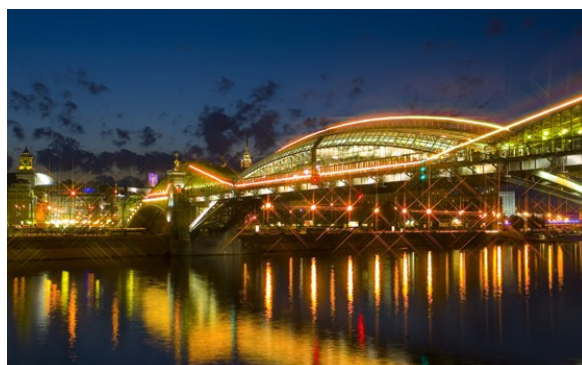
Рис. 3. Москва. Мост Богдана Хмельницкого
