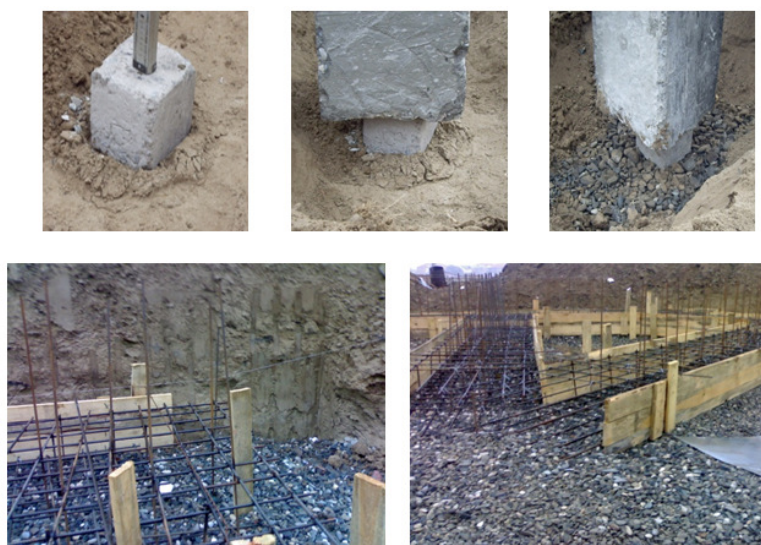
Рис. 2. Натурные испытания на намывном грунте, уплотненном щебнем
